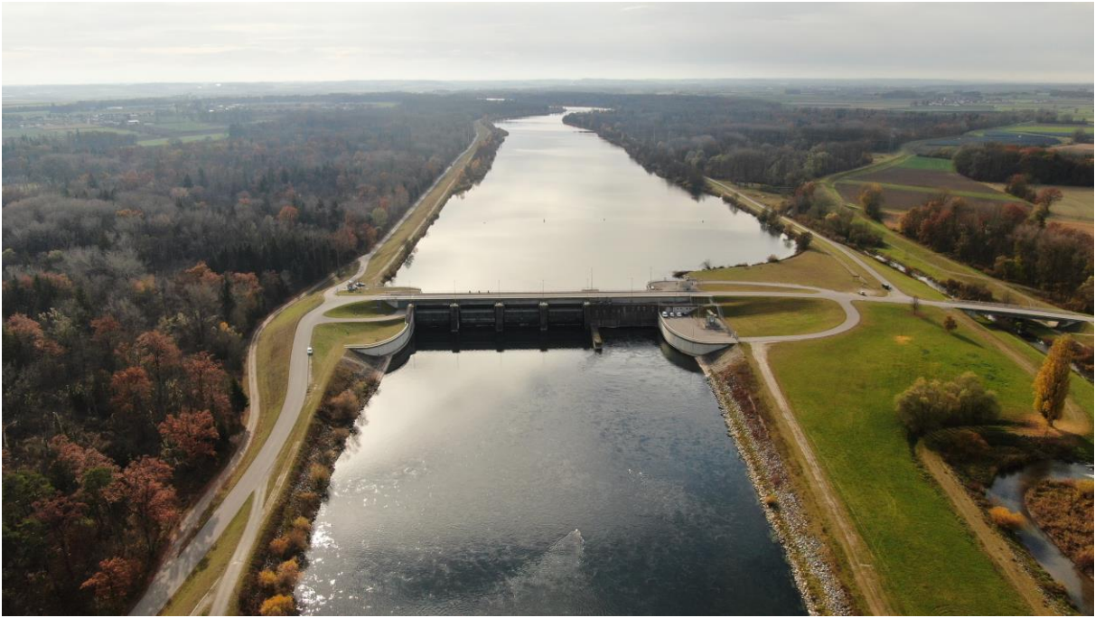
Drohnenbild der Stützkräftstufe Pielweichs (Bildrechte Wasserwirtschaftsamt Landshut)
