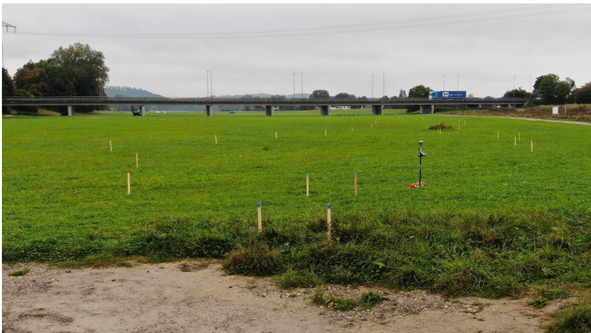
Foto 2 - Abstecken des Gewässerlaufs als Vorbereitung für den zweiten Bauabschnitt in der Flutmulde (WWA LA)
