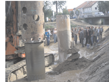
Herstellung der Bohrpfahlgründung
