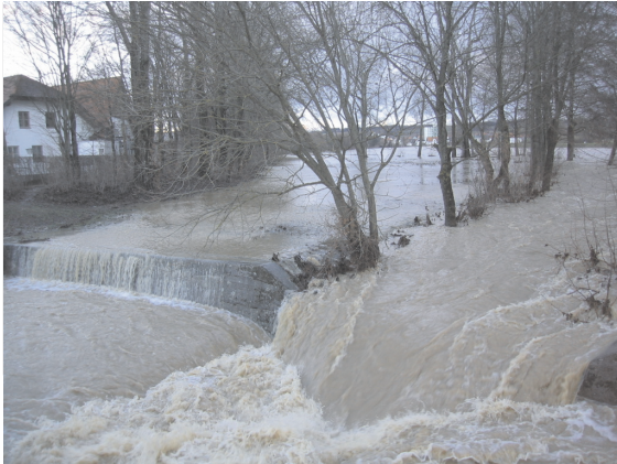
Hochwasser 2005 in Altdorf (Blick von der Parkstraße)
