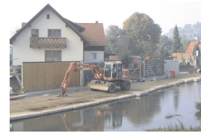
Errichtung der Hochwasserschutzmauer
