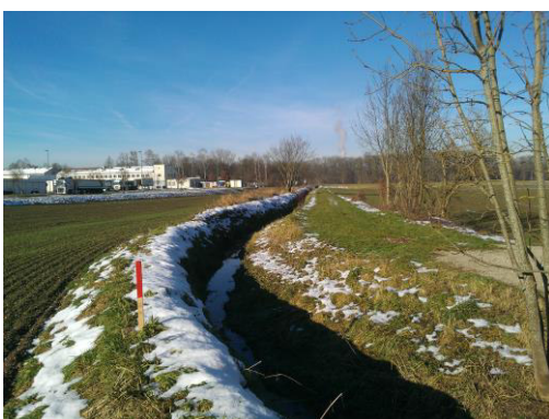
Abbildung 6: Überlaufstrecke des Schweinbachs
