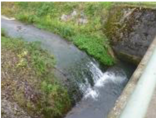
Abbildung 20: Querbauwerk am Teisbach
