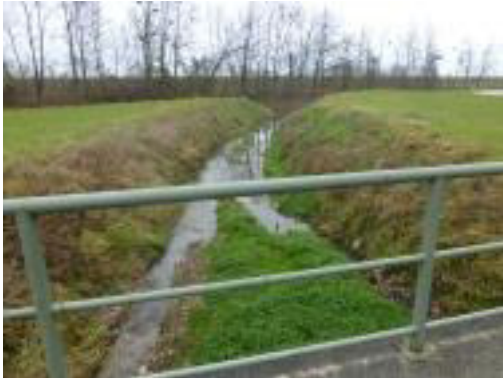
Abbildung 19: Teisbach vor Einmündung in den Sickergraben
