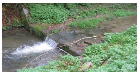
Abbildung 24: Abturm mit Uferbefestigung
