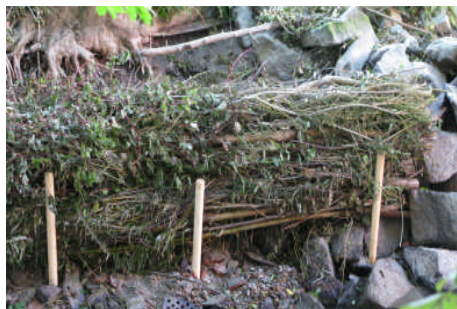
Abbildung 14: Faschinen als Strukturelement
