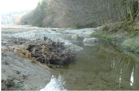
Abbildung 18: Strukturanreicherung mit Wurzelstock und Kies, Aichbach, Gemeinde Adlkofen
