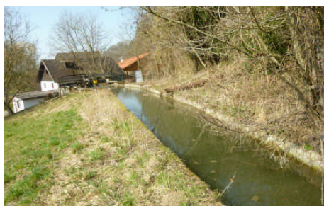
Abbildung 28: Ausleitungsstrecke mit Absturz
