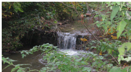
Abb. 30: Absturz, überwucherte Ufersicherung
