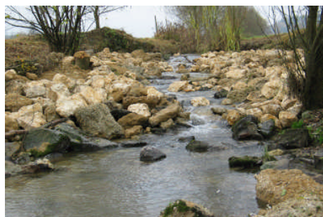
Abbildung 21: Sohlrampe – Umsetzungsbeispiel, Ausführung durch Studenten der Fachhochschule Weihenstephan, Furth im November 2005
