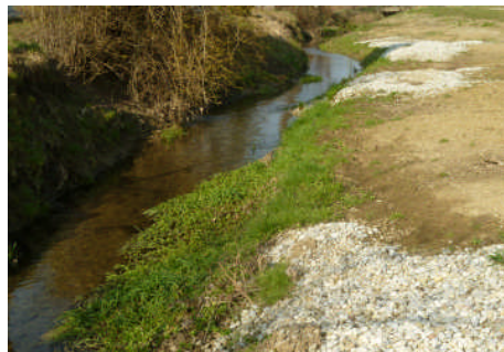
Abbildung 15: Bsp. Für eine Uferabflachung am Osterbach in Gündlkofen, Gde. Bruckberg
