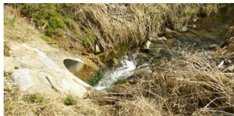
Abbildung 27: Einlauf oberhalb des Rohrs
