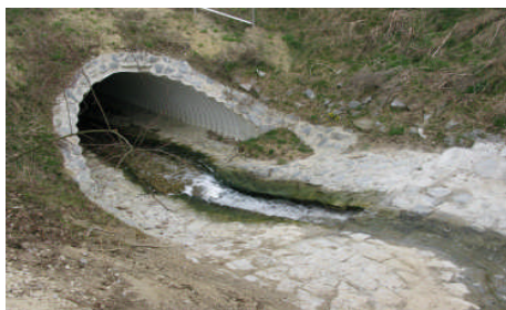
Abbildung 19: Rampe am Klärwerk Tiefenbach
