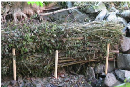
Abbildung 14: Faschinen als Strukturelement
