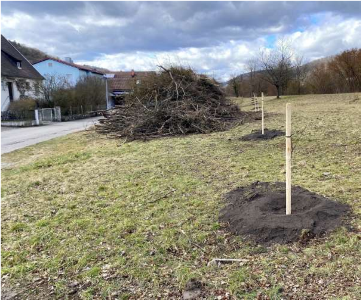
Foto WWA LA – Gehölzarbeiten und Ersatzpflanzungen Hochwasserdeich Mitterfeld
