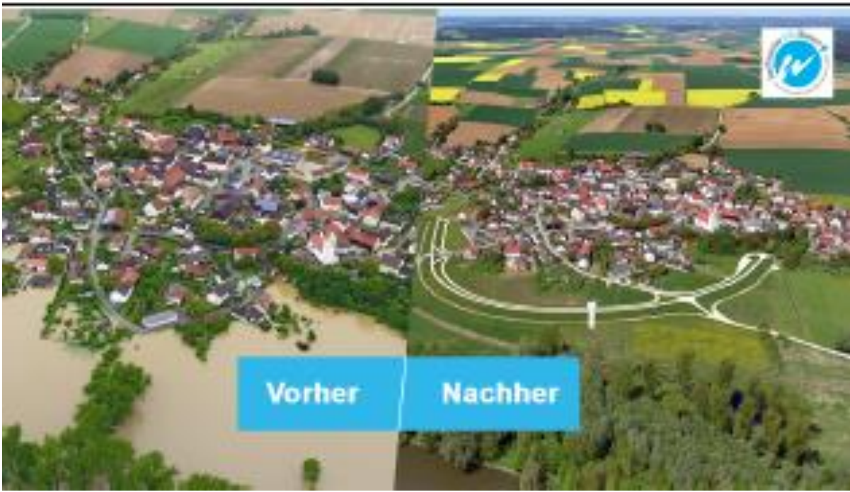
Foto WWA LA: Juni Hochwasser 2013 und Hochwasserschutz Hienheim
