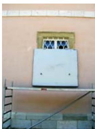
▼ Halbflächiger Fensterverschluss, am Fenstergitter fixiert.
