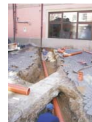
▲ Arbeiten im Klosterhof an der Binnenentwässerung
