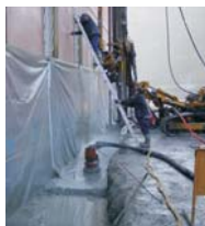
▲ Einbringen der Dichtwand im HDI-Verfahren
