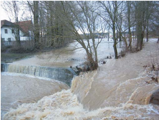
Hochwasser 2005 in Altdorf
