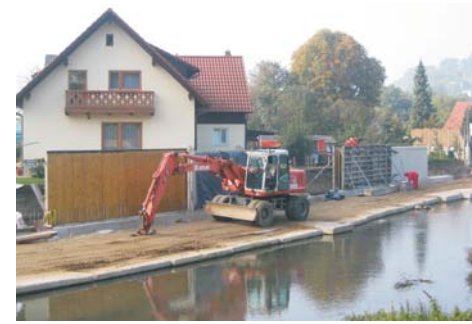
Errichtung der Hochwasserschutzmauer
