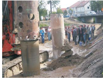
Herstellung der Bohrpfahlgründung
