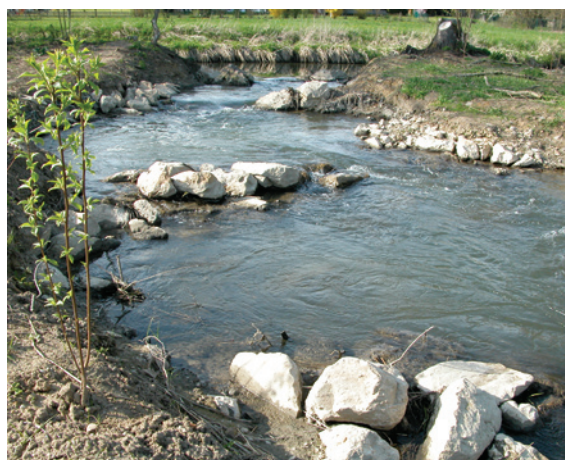
Neue Fischtreppe am Oberleierndorfer Wehr
